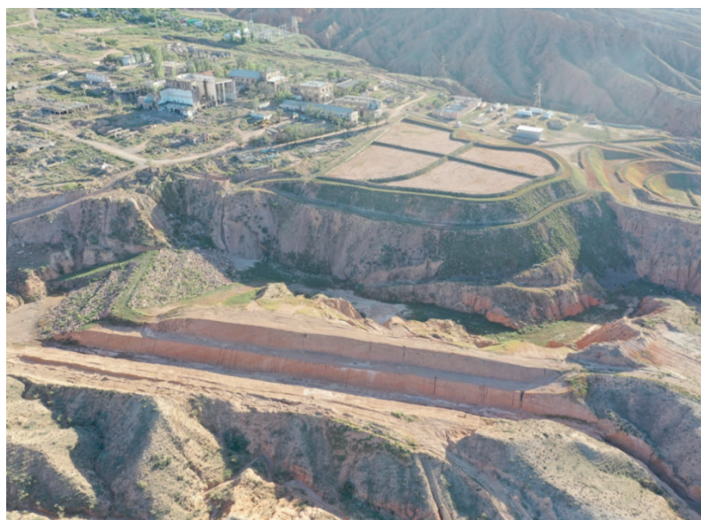
Рис. 2. Каджи-Сайское хвостохранилище после рекультивации
