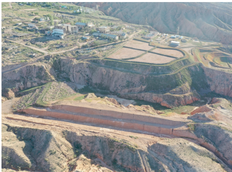
Рис. 2. Каджи-Сайское хвостохранилище после рекультивации
