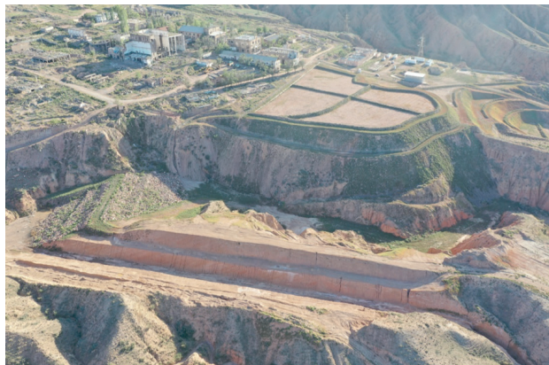
Рис.1. Каджи-Сайское хвостохранилище после рекультивации
